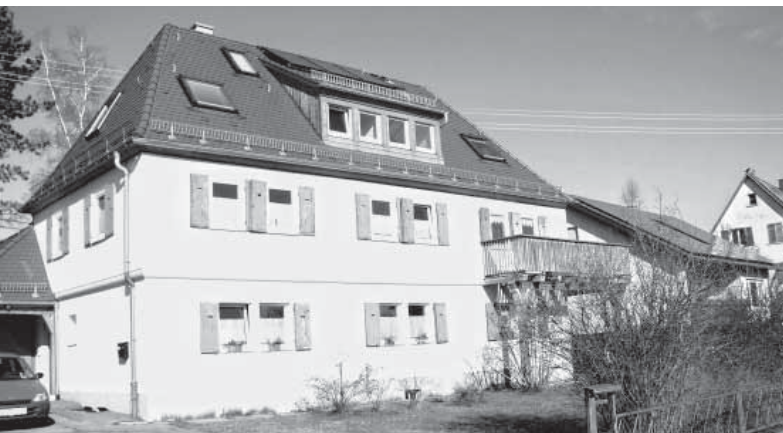
Ein Gebäude verändert sein Aussehen: Das Lebenshaus vor der Sanierung.
