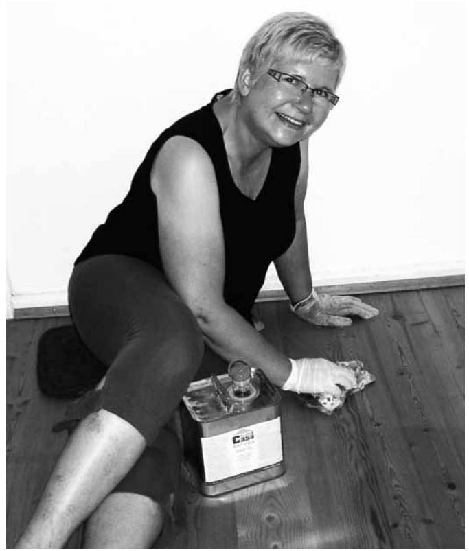
Vorbereitung für die Vergrößerung der Kerngruppe: Katrin Warnatzsch bei Renovierungsarbeiten an einem Holzboden.
