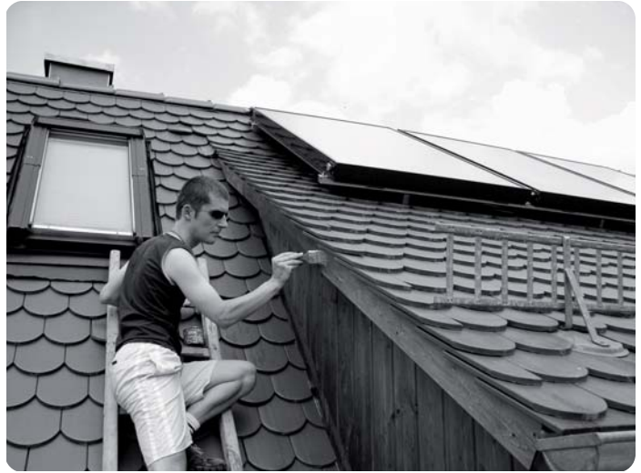
Auf das Dach des Lebenshaus-Gebäudes wurden inzwischen Sonnenkollektoren zur Brauchwassererwärmung montiert. Gleichzeitig nutzte Achim das dafür erforderliche Gerüst, um das Holz der Dachgaube neu zu streichen.
