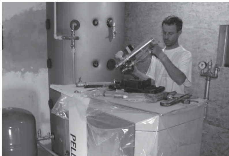
Im Heizungskeller entstehen neue Anlagen. Der bisherige Ölbrenner wird durch einen Pelletkessel (im Vordergrund) ersetzt. Die bestehende Solaranlage wird um weitere Module ergänzt, um so durch die Sonne Wasser in einem zusätzlichen Pufferspeicher (im Hintergrund) zur Heizungsunterstützung zu erwärmen.
